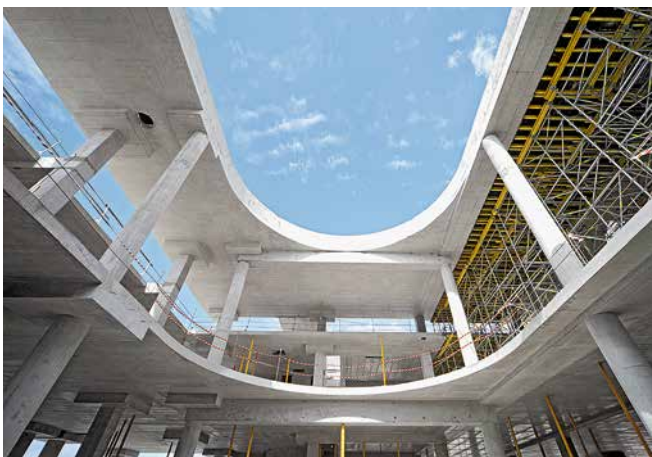
Železobetonové stropy s tloušťkou 30 cm byly obedněny systémem MULTIFLEX.
