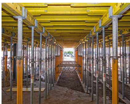
Při použití GT 24 je potřeba méně nosníků, ocelových pásů nebo stropních stojek. Přináší to s sebou nižší materiálové a mzdové náklady.
