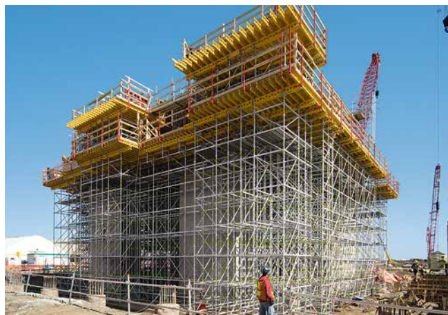
S PERI UP Rosett a MULTIFLEX bylo možné obrovská zatížení z masivních částí stavby ve výškách mezi 10 a 12 m spolehlivě přenést až do základů.
